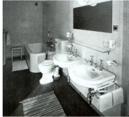
1935: Bad mit WC im Neubau.
